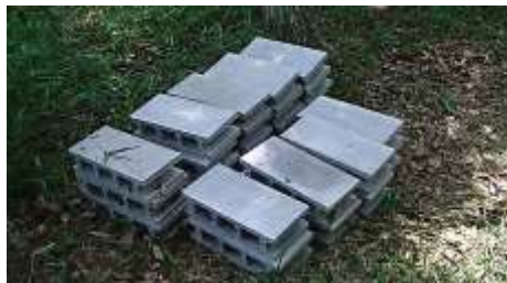
運び込んだ基礎用ブロック
