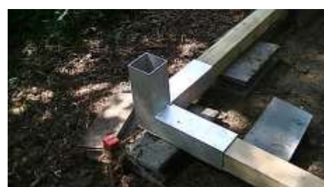
コーナーに使う特注アルミ枠の組み込み
