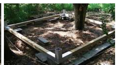
下部木枠を組立 つづきは次回
