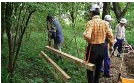
運び込んだ防腐木材
