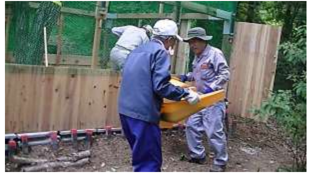
観察小屋内の傾斜解消に向けての盛り土作業
