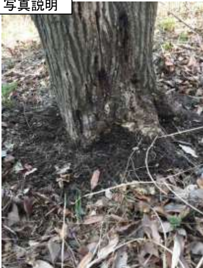
カシノナガキクイムシの被害と思われるコナラの根元部分の除草を行なった後
